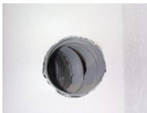
**Connexion bouche d'extraction** : conduit détérioré (pas de manchette de raccordement)
