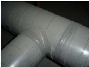
**Conduit** : étanchéité paraissant correcte
