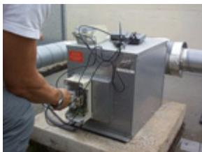
Les mesures électriques au ventilateur permettent de vérifier que celui-ci fonctionne à son point nominal et n'est pas en surcharge.
