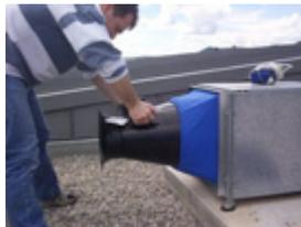
**Caisson de ventilation** : mesure de débit au rejet
