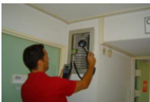
**Grille d'extraction** : mesure du débit extrait à l'aide d'un anémomètre à moulinet
