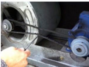
**Courroie** : détériorée, au bord
