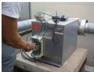
**Caisson** : mesure de la puissance électrique absorbée
